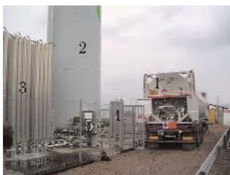
Фото 2. Криогенный комплекс приема, хранения и газификации СПГ:
