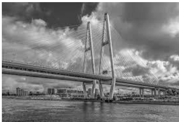
Рисунок 2. Большой Обуховский мост
