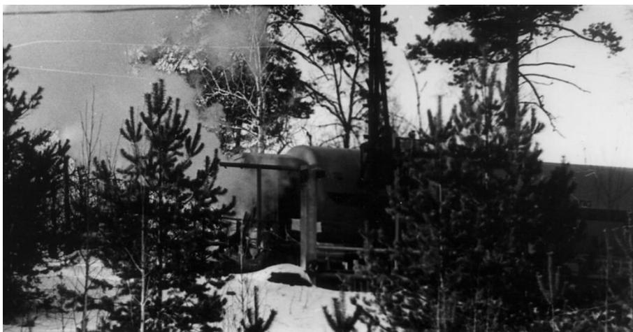
Рис. 4. Падение водорода в атмосферу через предохранительные устройства при вакуумировании в теплоизоляционном пространстве резервуара
