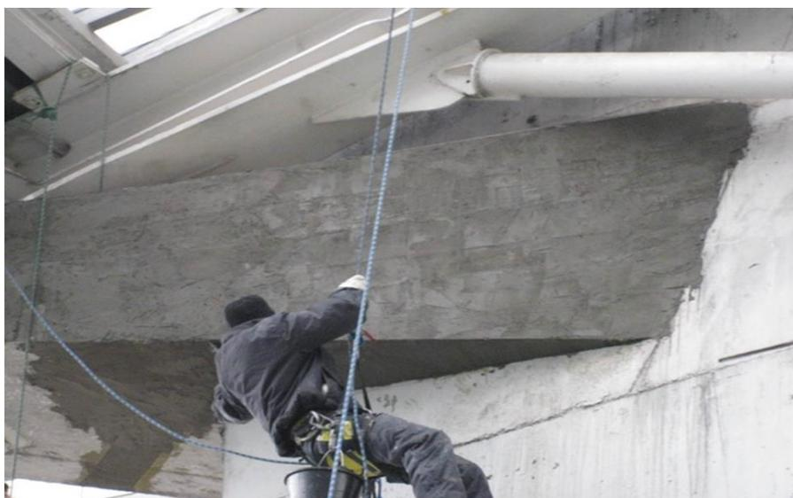
Рис. 2. Нанесение защитного полимерцементного состава
