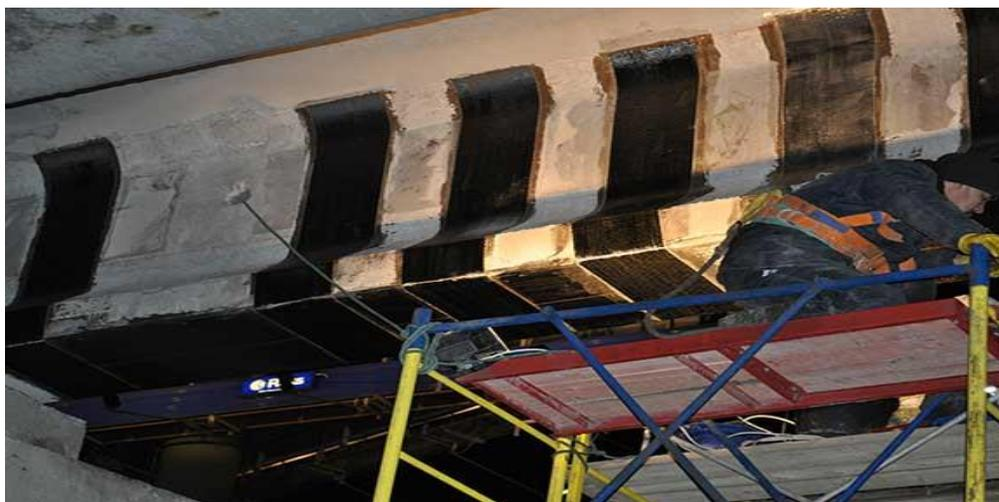
Рис. 1. Усиление балок композитными материалами
