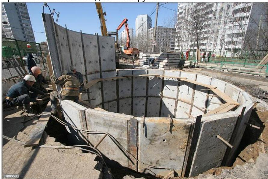
Рис. 3. Возведение конструкции сборного опускного колодца
