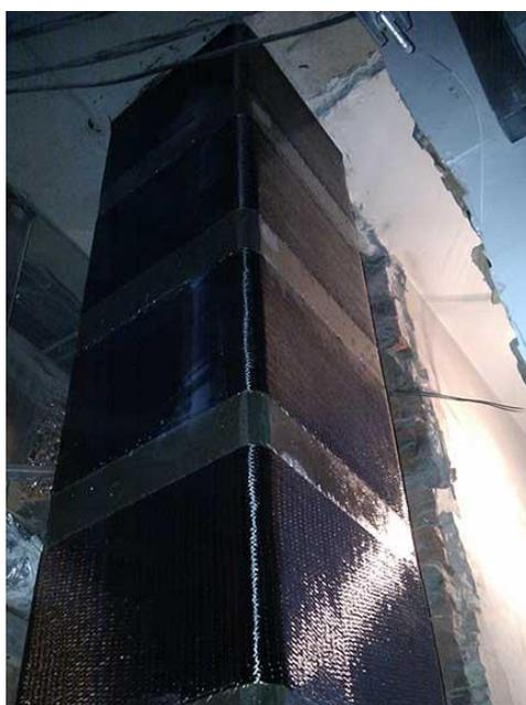
Рис. 2. Усиление колонн композитными материалами
