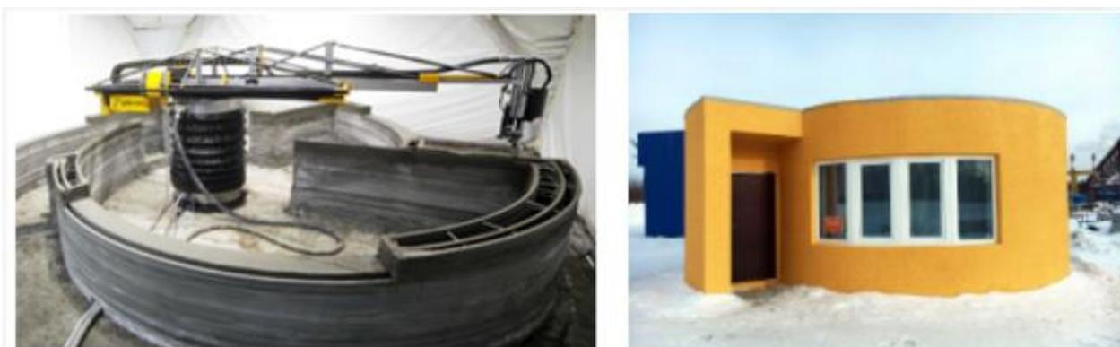
Рис. 4. Работающий 3D-принтер и итоговое здание
