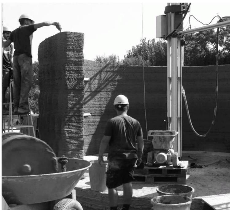
Рис. 2. Процесс возведения здания с помощью 3D-принтера
