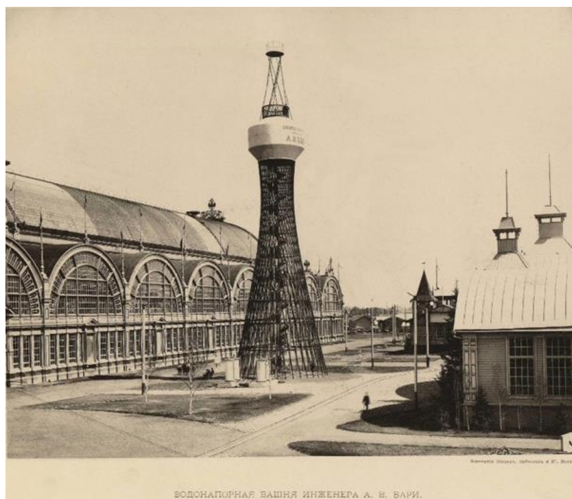
Рис. 1. Первая в мире гиперболоидная конструкция В. Г. Шухова на Всероссийской выставке в Нижнем Новгороде, фотография А. О. Карелина, 1896
