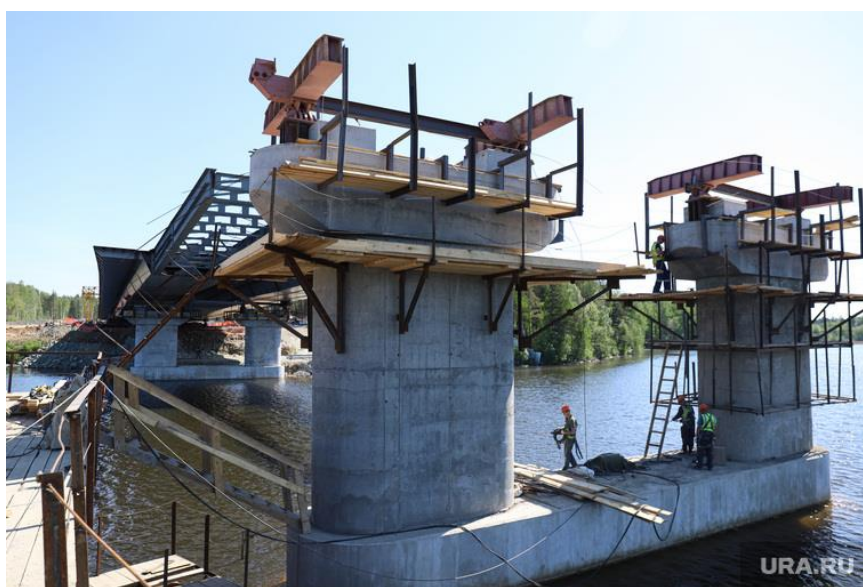
Рис. 8. Возведение железобетонных опор
