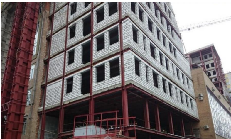
Рис. 1. Надстройка пяти этажей и пристройка двух 12-этажных блоков с несущим стальным каркасом к зданию (РАМН) в Абрикосовом переулке, д. 2, г. Москва https://ardexpert.ru/article/10226 (обращение 25.02.2024 г.)
