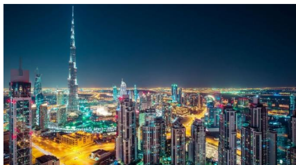
Рис. 2. Высотные здания в Объединенных Арабских Эмиратах
