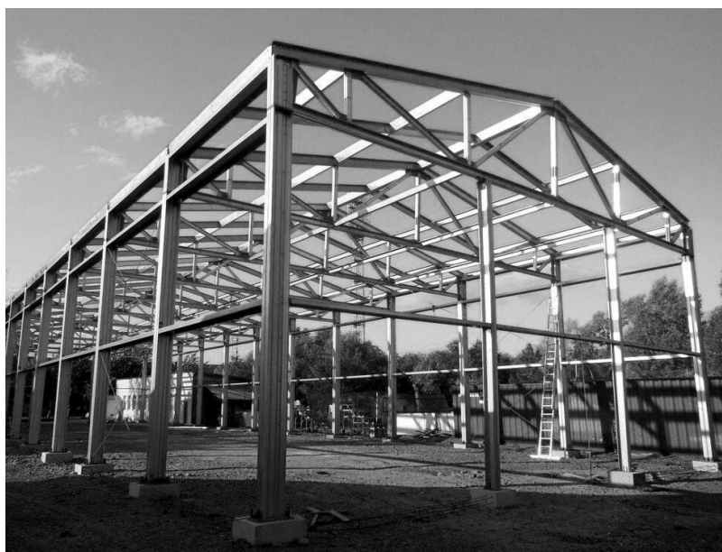
Рис. 1 Каркас здания из тонколистового проката
