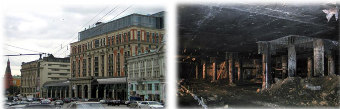
Рис. 3 Фасад отеля The Ritz Carlton и завершение разработки грунта на пятом подземном уровне отеля
