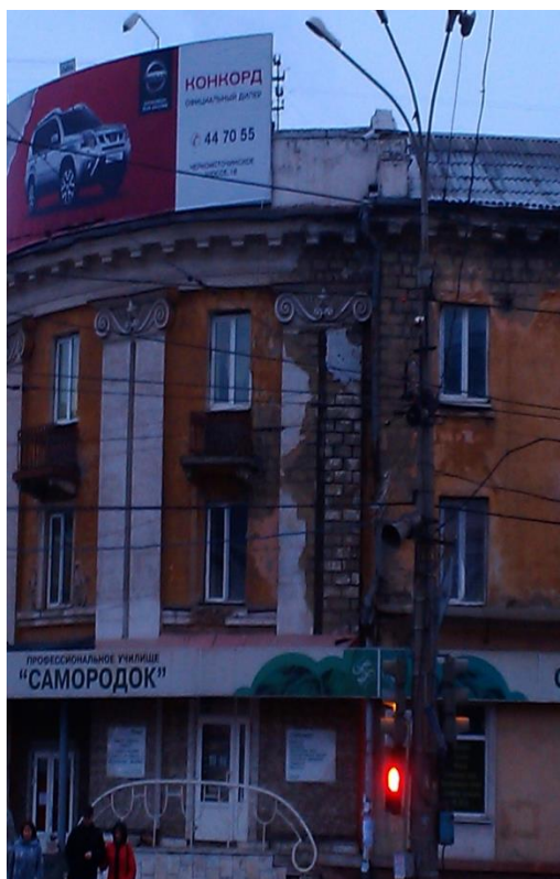
Рис. 2, 3. Разрушение фасада в местах установки водосточных труб
