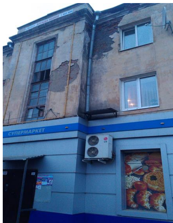
Рис. 2, 3. Разрушение фасада в местах установки водосточных труб
