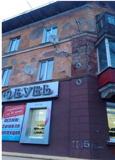
Рис.6, 7. Примеры плохой адгезии материалов фасада
