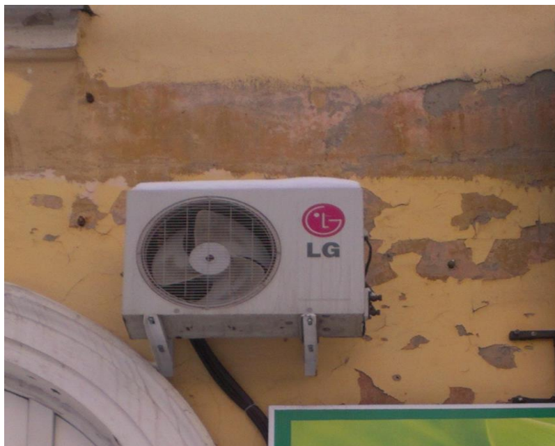
Рис.5. Пример неправильного подбора материалов: современные лакокрасочные составы на полимерах плохо сцепляются со старыми побелками
