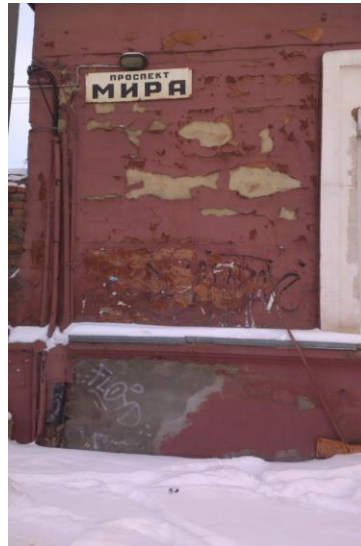
Рис.6, 7. Примеры плохой адгезии материалов фасада
