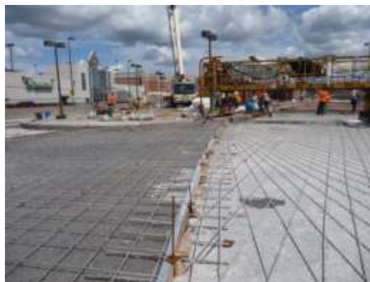
Рис. 2. Армирование асфальтобетона
