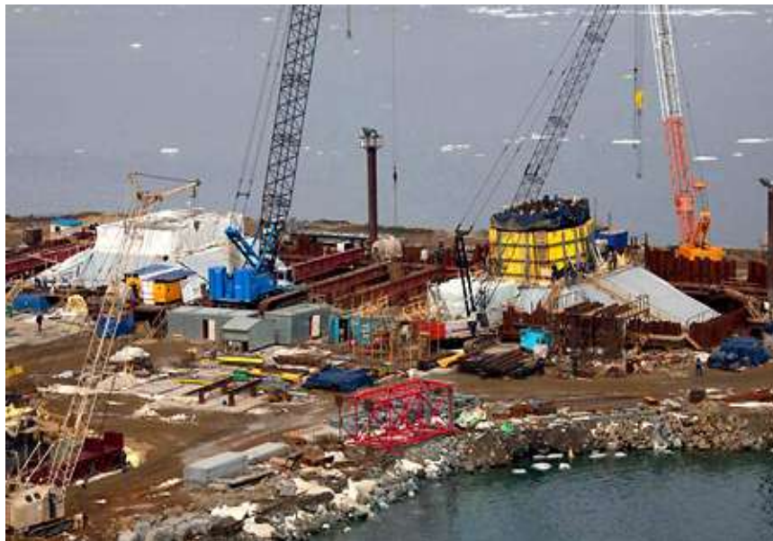
Рис. 5 Сооружение ростверка пилона М6
