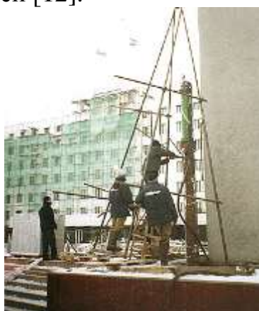
Рис. 3. Погружение свай при реконструкции здания Государственного Собрания Республики Марий Эл
