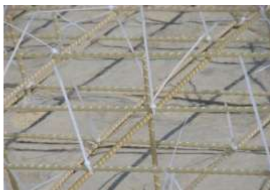
Рис. 3. Вязка пластиковыми хомутами
